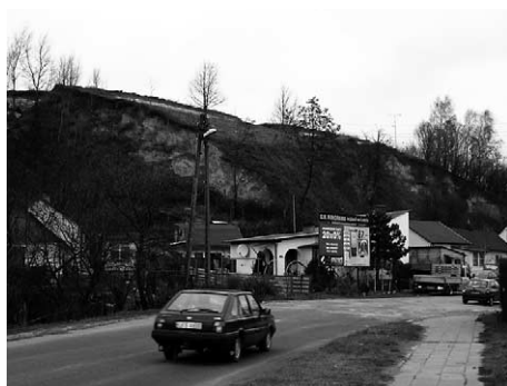
Fot. 3. Osuwisko w Krasnymstawie (fot. A. Borecka)
