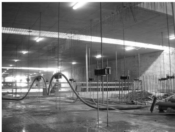
Ryc. 2. Widok podwieszonego stropu pośredniego w dwupoziomowej części stacji
