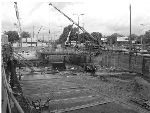
Ryc. 1. Widok wykopu stacji Marymont; etap realizacji stropu górnego
